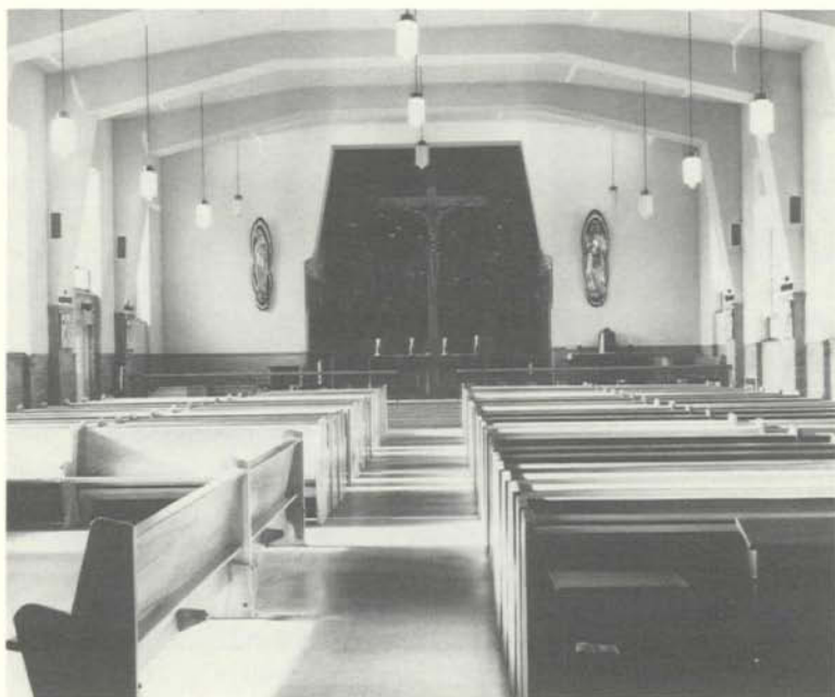
La chapelle de l'établissement Leclerc.
