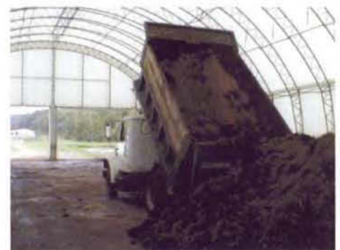
Andains de compostage à maturité (après le traitement/fin du procédé de compostage) Centre de compostage, Établissement Westmorland
