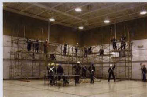
Les employés grimpent dans les hauteurs par l'échafaudage installé dans le gymnase de l'établissement Westmorland.
