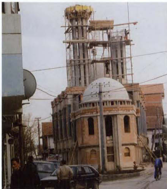
Une nouvelle mosquée en construction
